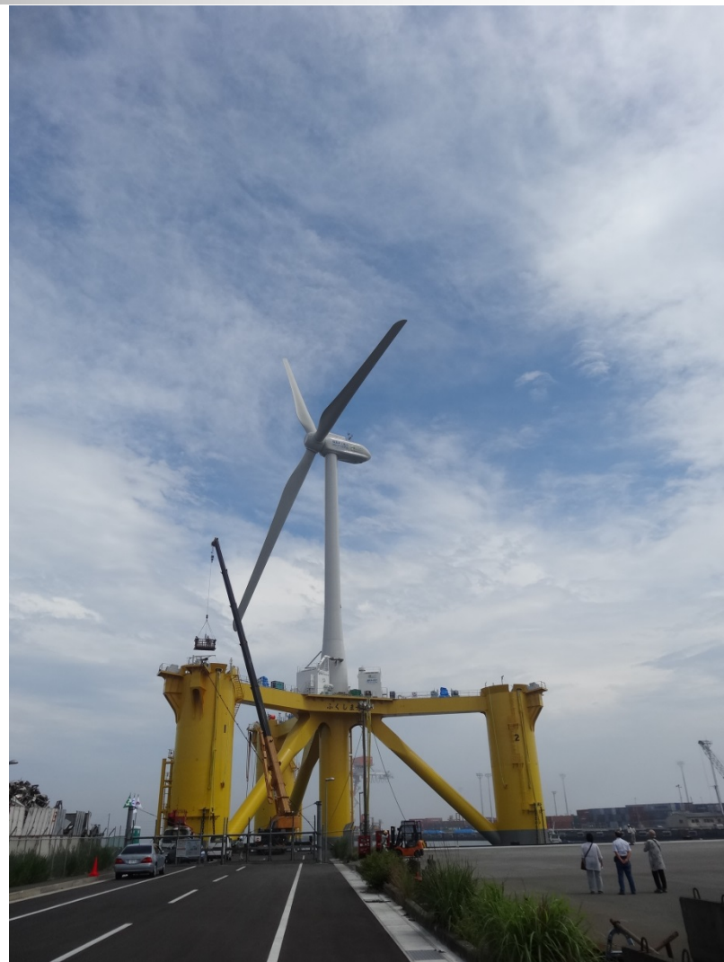
浮体式洋上風車(福島県沖)
