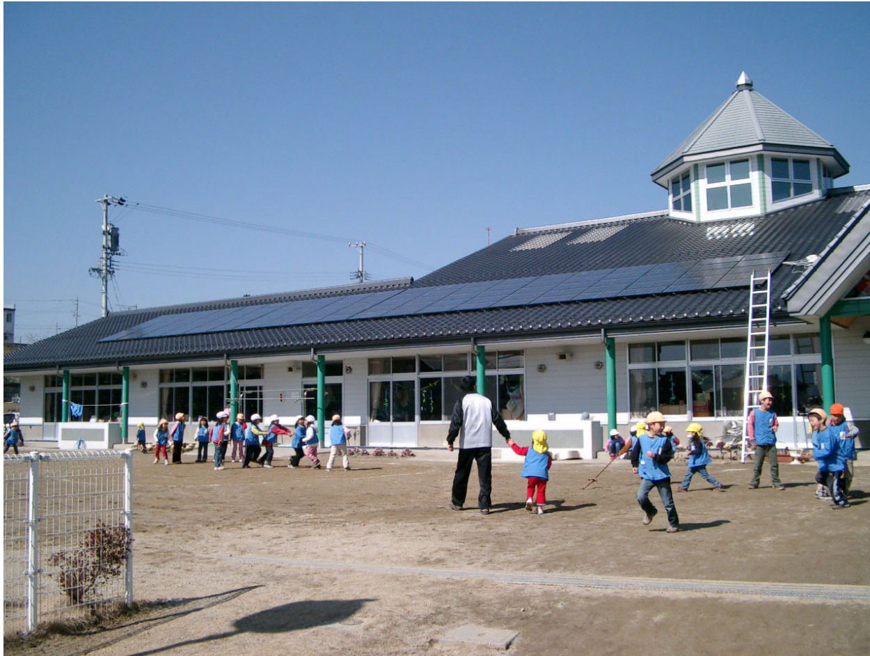
長野県飯田市 おひさま発電所
